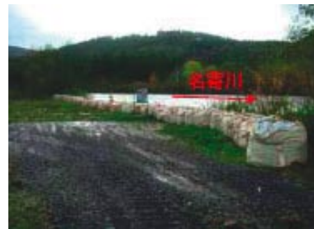
下川町三の橋地区 堰堤の右岸側から名寄川の水があふれて浸水した。無堤防地区なので堤防があれば浸水を防ぐことができた。ここはサンル川との合流点よりも上流だからサンルダムの効果はおよばない。
